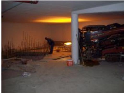
Die Ditch Witch JT3020AT (HDD Bohranlage mit patentiertem Felsbohrsystem) wurde in der engen Tiefgarage platziert. Die Abgase der Felsbohranlage von Ditch Witch wurden über einen ca. 30 m langen Schlauch durch das Treppenhaus geführt, ebenso wie die Bohrspülung da der LKW mit der Mischeinheit neben dem Hotel stand.
