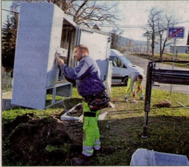
Yves Willert und Alexander Schmidt (vorn) aus Apolda von der Firma „Rhönmontage stellen einen Schaltschrank auf. Foto: Bernd Rödger
